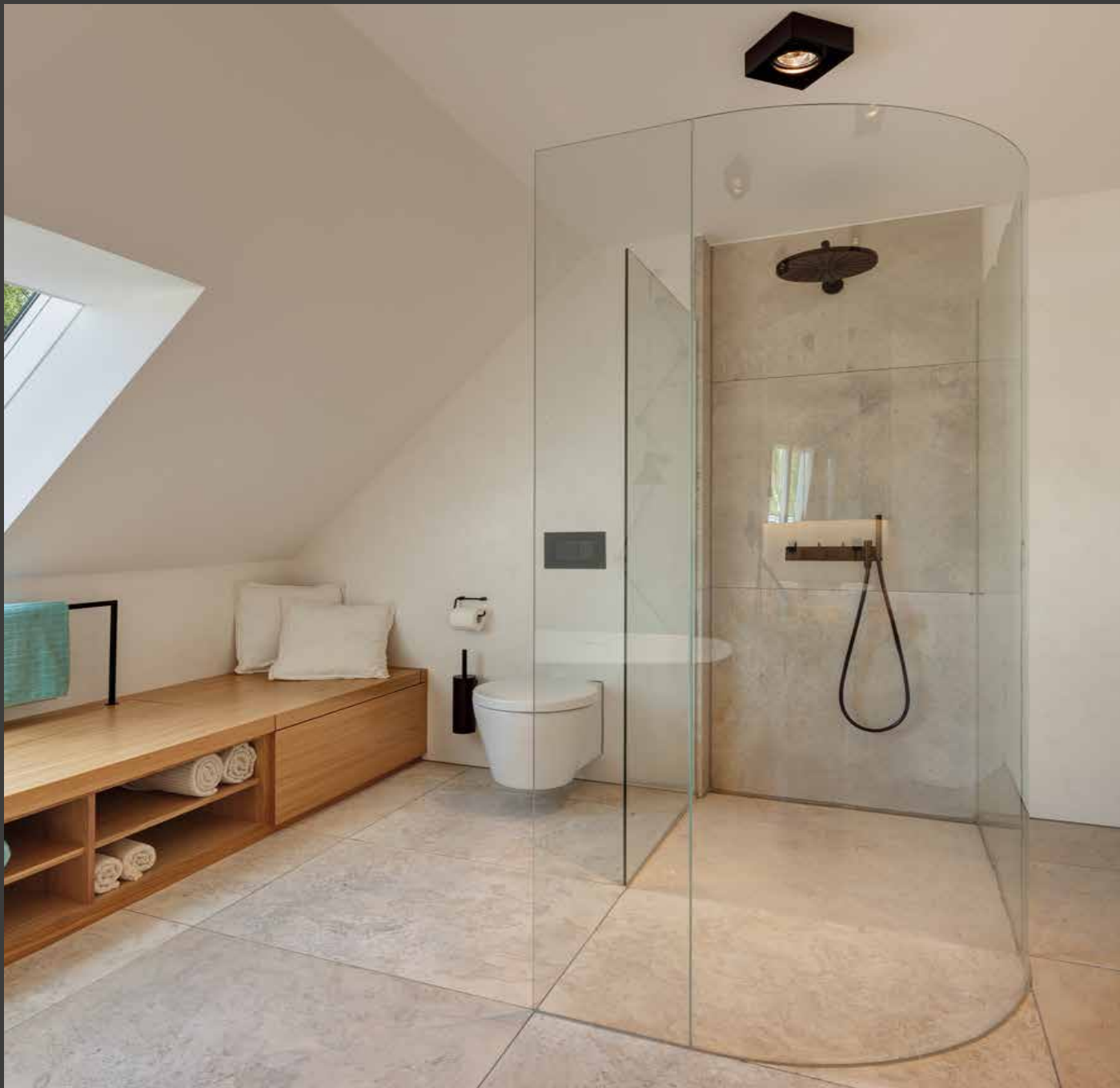
unikat absolut, Sonderlösung mit individuell gebogener Rundscheibe, ohne Metallbeschläge, nur geklebt.
